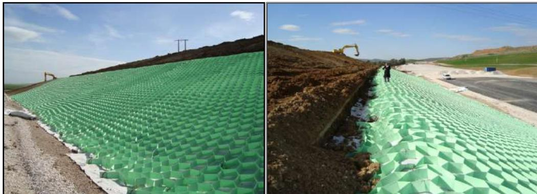
Figure7 et 8. Les deux géosynthétiques mis en œuvre.
