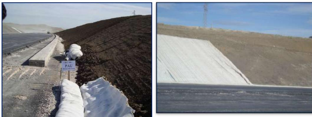
Figure 6. Mise en œuvre du géocomposite de drainage.
