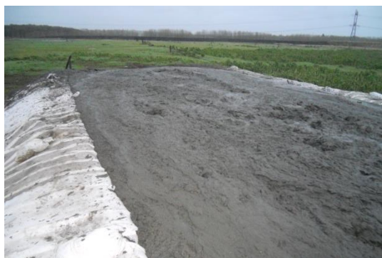
Figure 1. Alvéole de test en grandeur réelle avec le géocomposite et les sédiments de dragage (Source : Baudalet Environnement).
