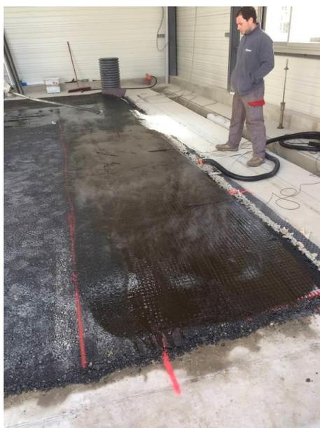
Figure 1. Second géosynthétique, intelligent et renforçant, juste après installation
