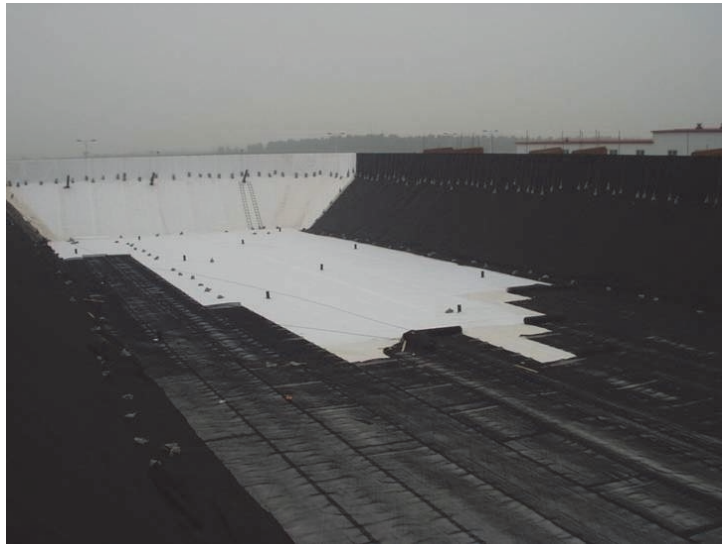
Figure 5. Vue du bassin de Tianjin Xinjan (Chine) en chantier.
