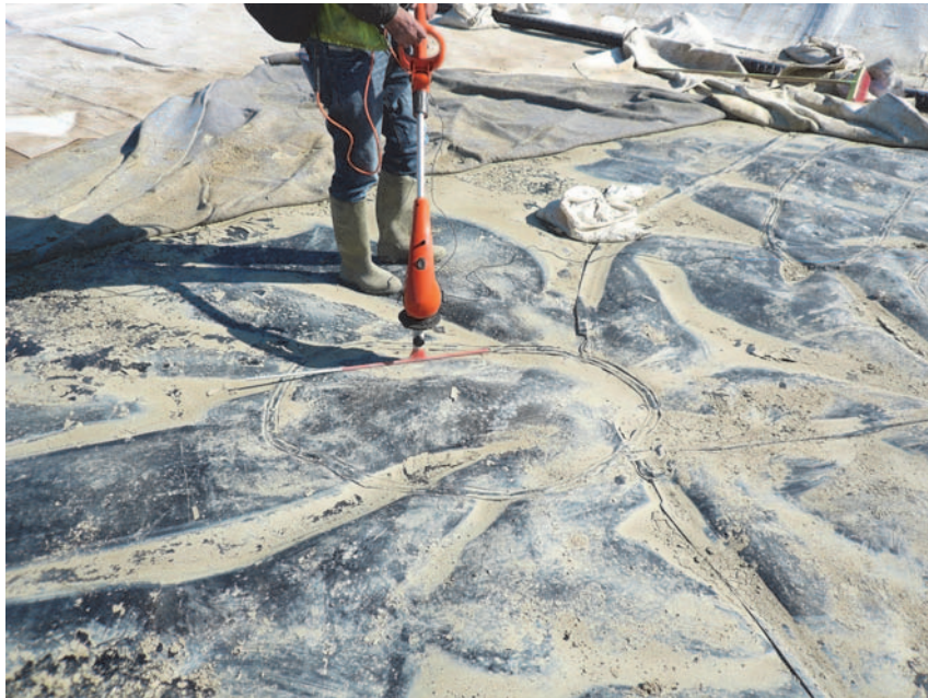
Figure 6. Second passage du balai après réparation.
